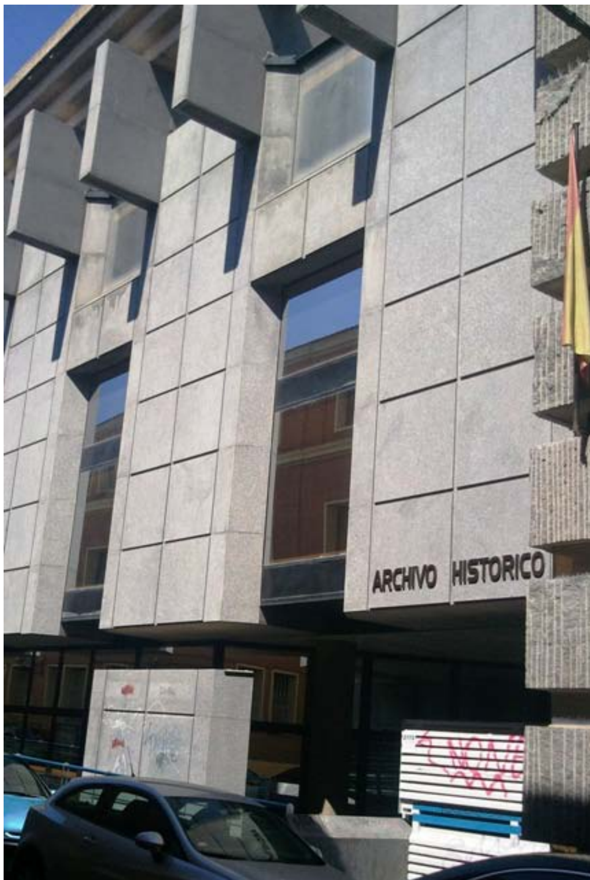
Edificio del Archivo Histórico Provincial de Palencia
