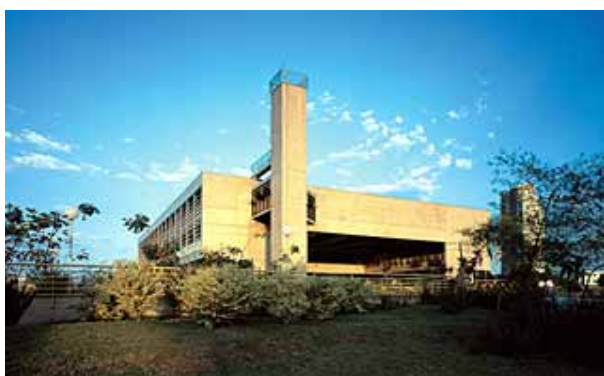
FOTO 4.3.2 - VISTA ACESSO BLOCO ADMINISTRATIVO
