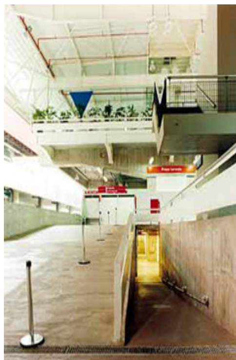
FIGURA 4.2.4 – Rampa de acesso ao subsolo, onde estão áreas de apoio, como vestiários, transformadores e refeitório FONTE: www.arcoweb.com.br/arquitetura/arquitetura77.asp AGOSTO 2003
