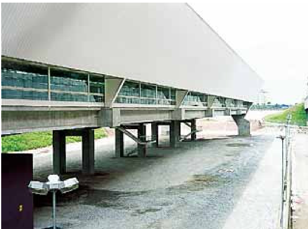
FIGURA 4.2.3 – Poupatempo Itaquera, São Paulo-SP – Pavilhão Suspenso FONTE: www.arcoweb.com.br/arquitetura/arquitetura77.asp AGOSTO 2003
