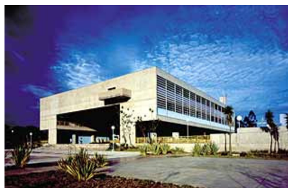
FOTO 4.3.3 - VISTA LATERAL BLOCO ADMINISTRATIVO
