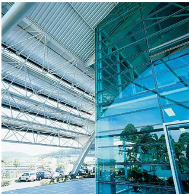
FOTO 4.1.2 - A estrutura é ancorada no solo e a cobertura é recortada por brises com estrutura semi-espacial, que vence vãos de 12,5 metros em quatro degraus FONTE: www.arcoweb.com.br/arquitetura/arquitetura392.asp AGOSTO 2003
