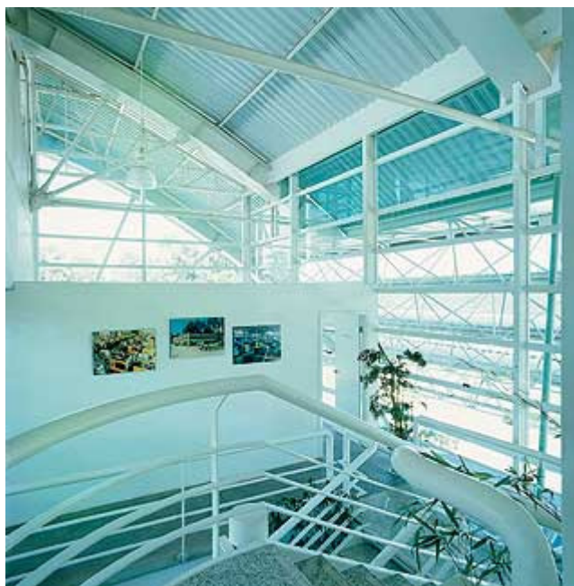
FOTO 4.1.4 - A integração dos caixilhos de forma coordenada e compatibilizada garante a idéia da curva da cobertura totalmente solta, sem barreiras
