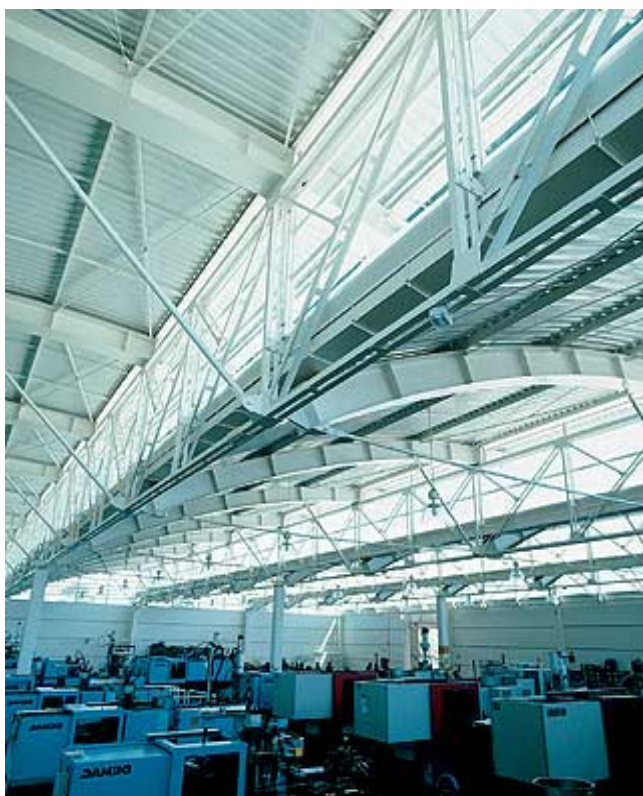
FOTO 4.1.6 - As tesouras em arco da cobertura têm sistema de contraventamento horizontal. As vigas-mestras vencem vãos de 25 metros na área da fábrica
