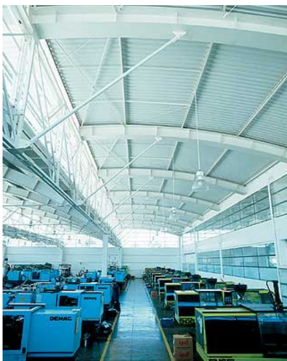
FOTO 4.1.5 - Sheds com vidro laminado permitem a entrada de luz natural na área de produção, conferindo bons níveis de conforto ambiental no interior da fábrica FONTE: www.arcoweb.com.br/arquitetura/arquitetura392.asp AGOSTO 2003
