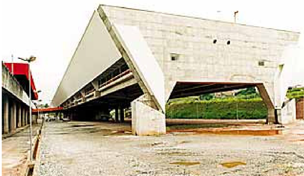
FIGURA 4.2.1 – Poupatempo Itaquera, São Paulo-SP – Pavilhão Suspenso FONTE: www.arcoweb.com.br/arquitetura/arquitetura77.asp AGOSTO 2003
