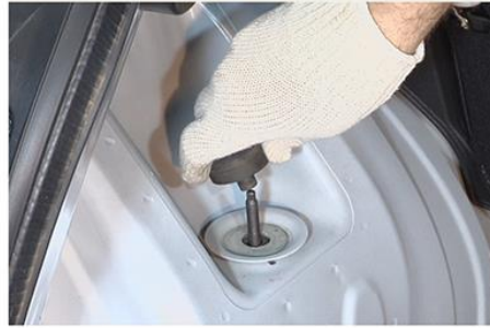
Fig.13 - Instalação do apoio de borracha
