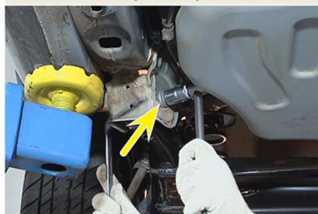
Fig.4 - Desaperto dos parafusos das buchas de fixação do eixo de torção à carroçaria
