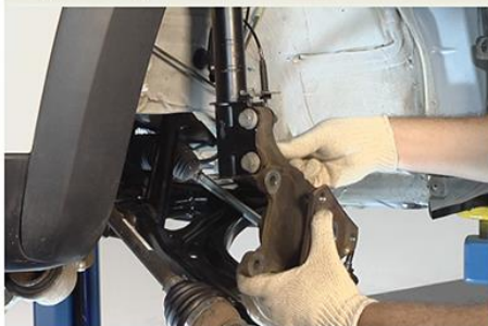
Fig.13 - Desaperto das porcas fixadoras da torre
