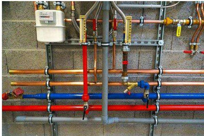
Por otro lado, las tuberías de agua fría y agua caliente deben tener una separación de 20 cm; las salidas del agua caliente siempre se colocan del lado izquierdo y por
