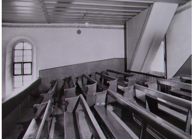
Die Empore – noch ohne Orgel (Zustand vor der Restaurierung im Jahre 1964). Interessantes Detail: das umlaufende Wand-Ornament unmittelbar unterhalb der Holzdecke
