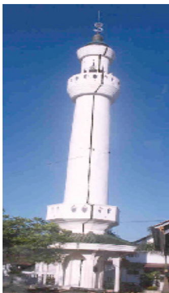
Gambar 6.5 Pada saat terjadi petir, pengosongan listrik statis dari bagian bawah awan yang bermuatan ke Bumi akan melewati batang penangkal petir ini. Muatan listrik akan mengalir ke bawah dengan aman melalui kabel logam tersebut, dan masuk ke dalam tanah.
