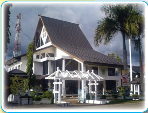
Gambar 4 Kantor Bupati Tabalong sebagai salah satu tempat penyelenggaraan Pemerintahan Kabupaten. Sumber : http://www.tabalong.go.id
